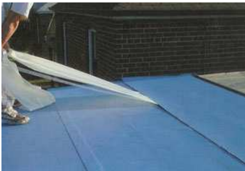
Membrane élastomère. Source : www.couvretoit.ca (Janvier 2008)
