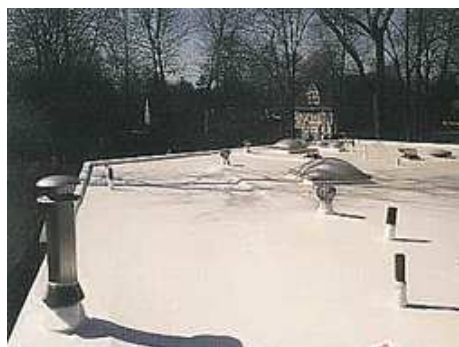
Membrane polyurée Source : www.duro-last.com (Janvier 2008)
