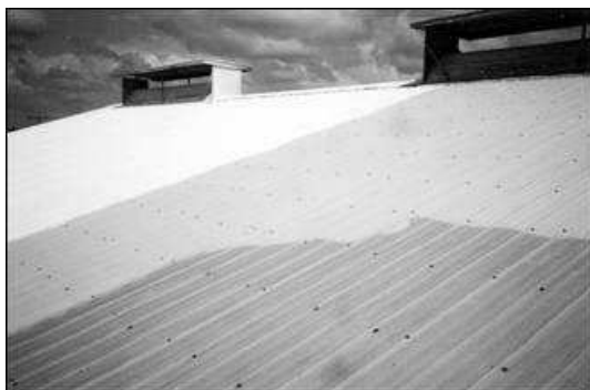
Enduit réfléchissant pour toit.
